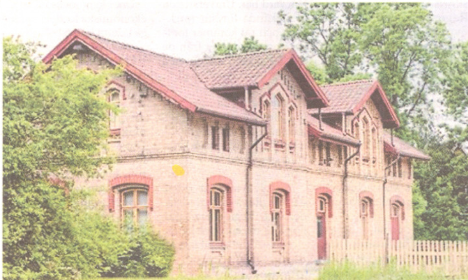
Det gamla stationshuset i Röstånga har legat i dvala i två år men om allt går vägen öppnar det upp en ny restaurang lagom till påsk nästa år.
